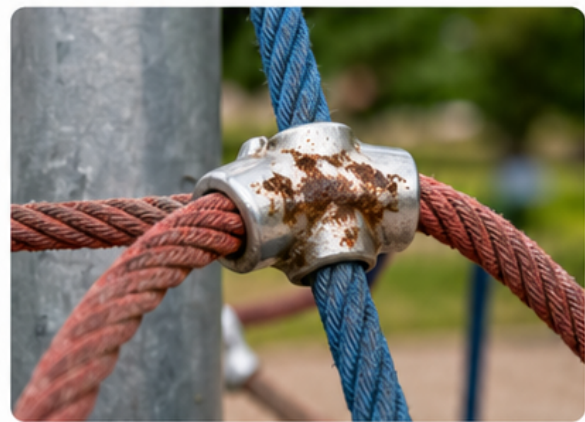
DETAIL – VERBINDUNGSKLEMME
