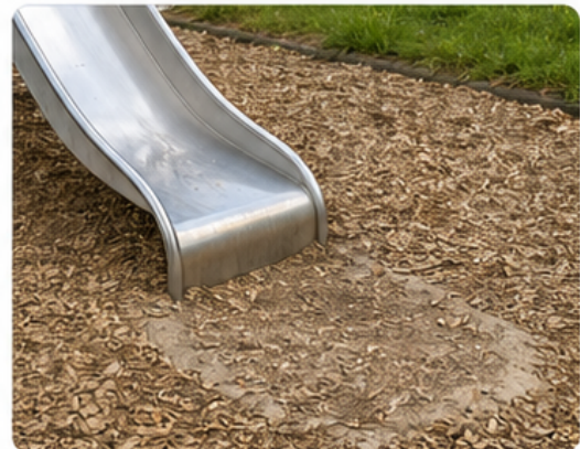
Detail: Rutschauslauf / Fallschutzbereich
